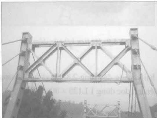
Hình 5.11: Hệ liên kết tháp cầu
