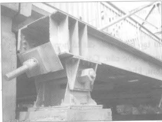
Hình 5.8: Cấu tạo dầm dọc
