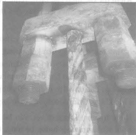
Hình 5.6: Ảnh chi tiết neo cáp
