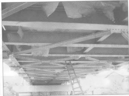
Hình 5.9: Hệ liên kết các dầm dọc
