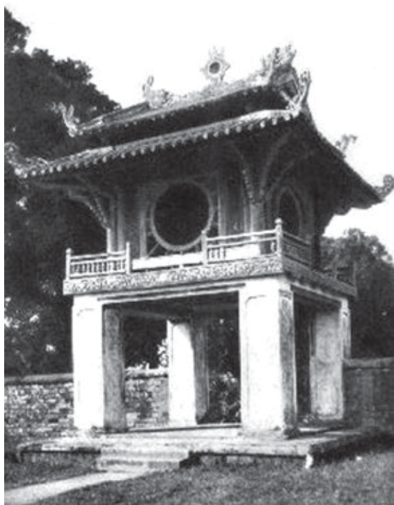
Khuê Văn Các - Văn Miếu được xây dựng thời Hoàng Thái hậu
